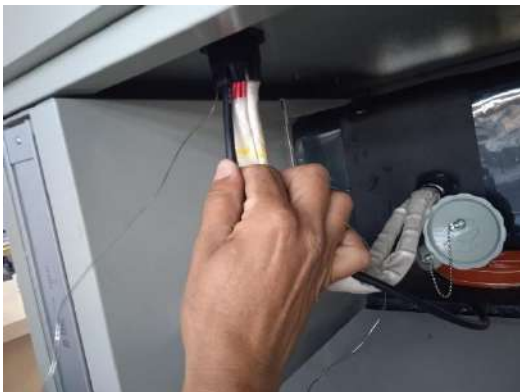
Ilustración 12: extracción cables de la resistencia
