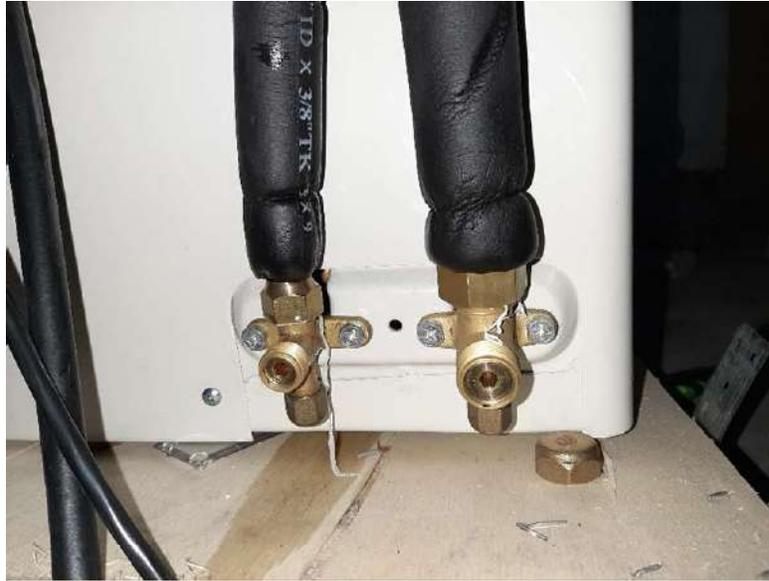
13. Revisar que la presión manométrica del refrigerante sea de 120 psi, si existe presión mayor a 120 psi, liberar un poco de gas para nivelar la presión, en caso contrario si le falta un poco de refrigerante agregar más hasta nivelar la presión. Asegurarse de que no entre aire al sistema de refrigeración
