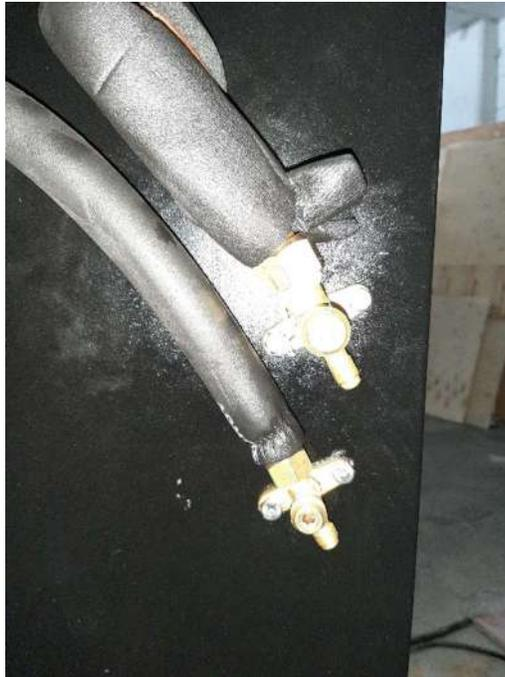
8. Realizar vacío por 15 minutos hasta que el manómetro indique 0 presión
