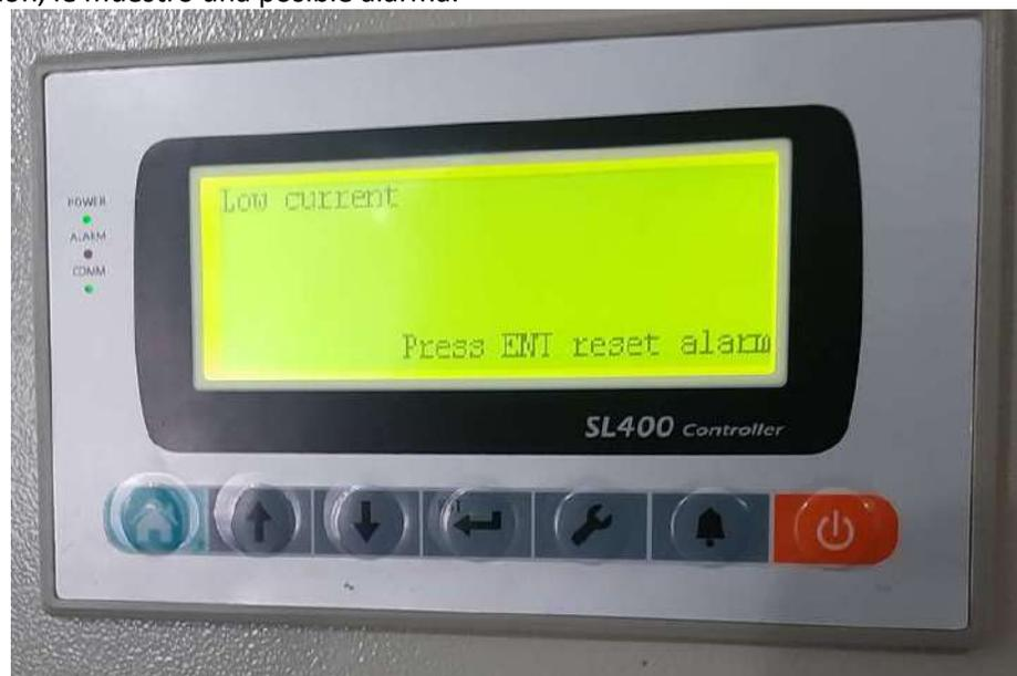
En el caso de esta alarma, debe presionar ENTER y posteriormente el símbolo de la llave. Esta alarma indica baja presión de agua o que el agua puede contener sedimentos.
