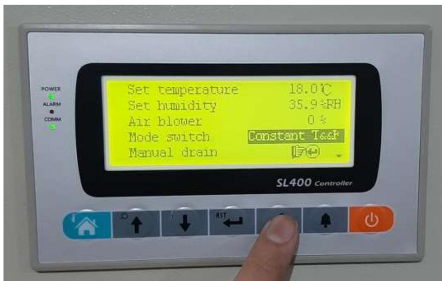
El siguiente parametro es para drenar el tanque del humidificador manualmente, este boton es opcional aplicarlo, ya que el humidificador se drena automaticamente una vez que deja de usar.
