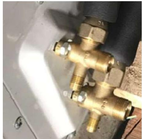
4. Conectar el manómetro para refrigerante en la conexión de baja presión (la tubería más gruesa) y mantener cerrado el manómetro
